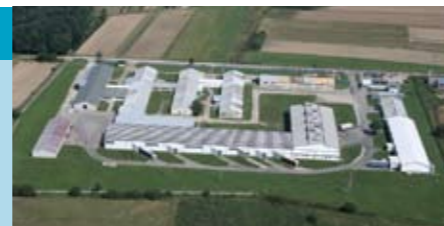
DAS NEUE WERK von FK-Protech in Kroczyzna, von dem derzeit nur ein Viertel der Fläche in Benutzung ist.
